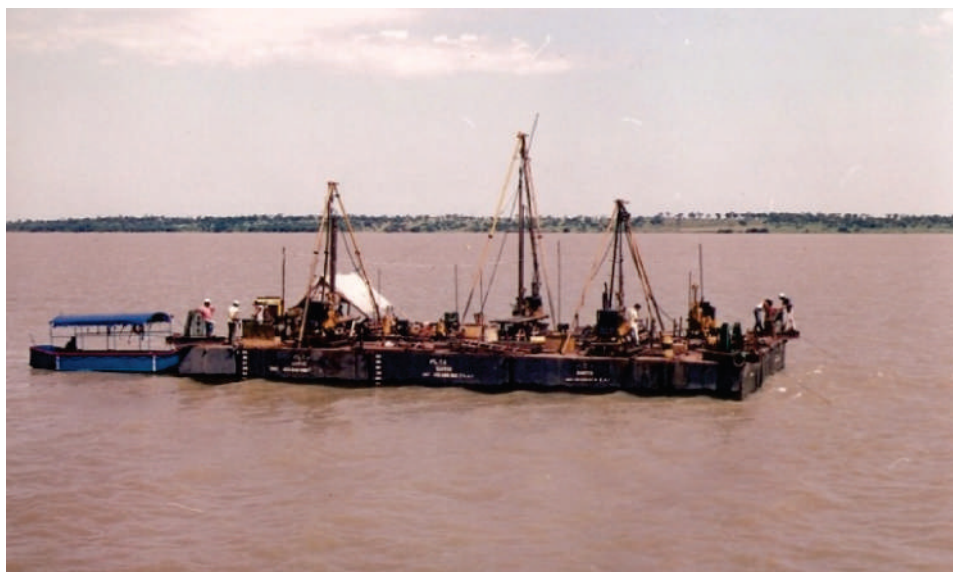
Figura 34 – Sondagem rotativa em balsa no Rio Paraná.
